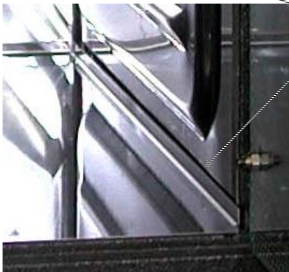
Obr.12 Trouba: Výstupky trouby musí být obráceny směrem nahoru
