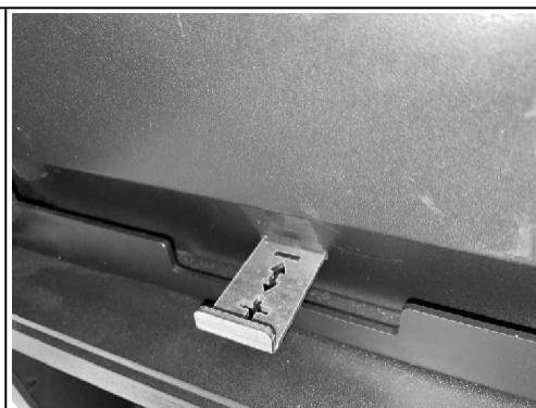
Zařízení pro regulaci sekundárního vzduchu: v této poloze je otevřeno na 100 %.
