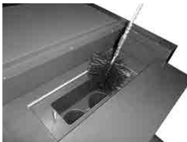
Důkladné vyčištění trubkového výměníku (trubkovnic) kartáčem
