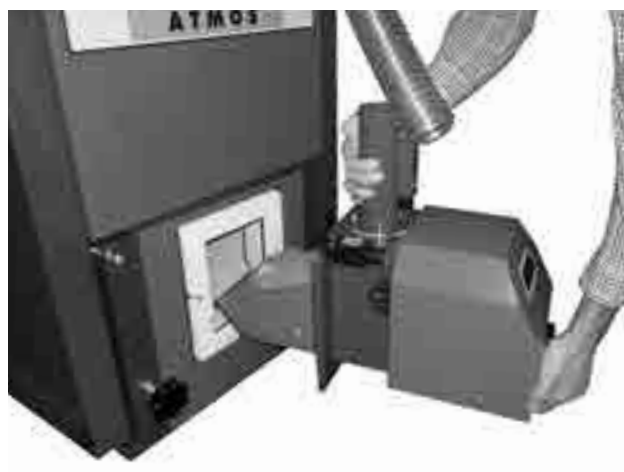
Vyjmutí hořáku z kotle při roční údržbě a čištění
