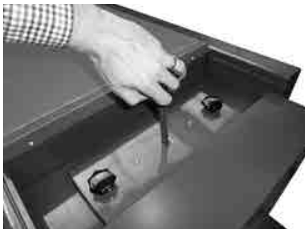
Ukázka provozního čištění trubkového výměníku a brzdíčů krátkými pohyby nahoru a dolů
