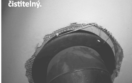
Špatné napojení na sopouch - netěsní a není čistitelný.
