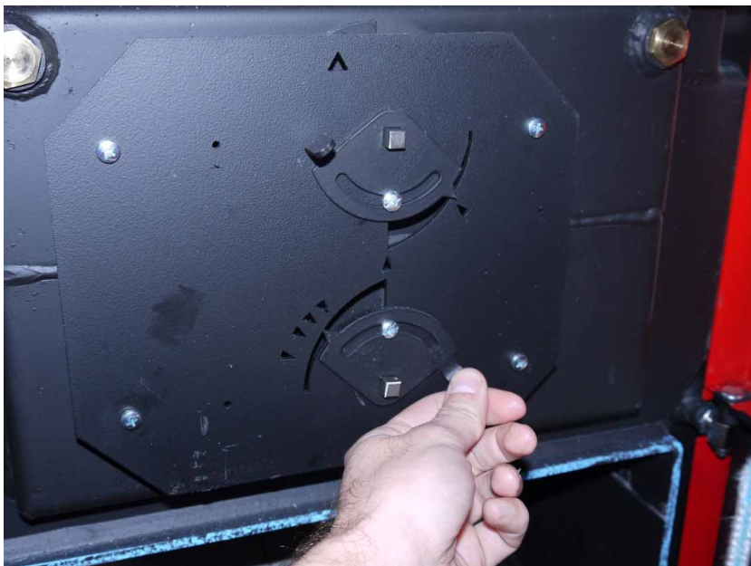
Nastavenie kotla DPX pre spaľovanie dreva (primárna a sekundárna klapka otvorená).
