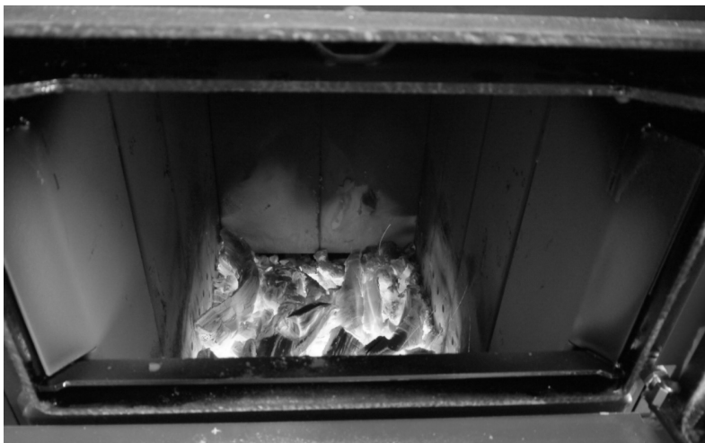
Obr. 13 Výška pahreby vhodná k priloženiu.
