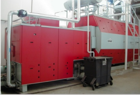
Spálenský – dřevěné lišty VERNER GOLEM 1 800 kW
