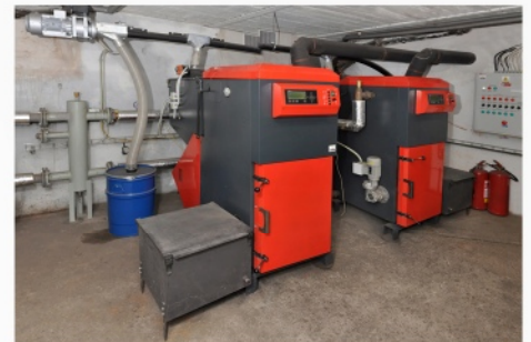
Obecní úřad a sokolovna Vlčice Kaskáda automatických kotlů VERNER
