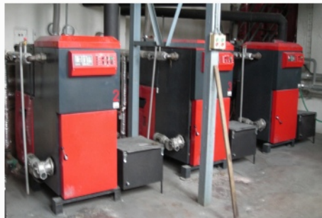
Poliklinika Broumov Kaskáda automatických kotlů VERNER
