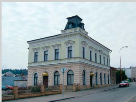
Administrativní budova - kotelna je umístěna v přízemí budovy. V obdobných objektech však byly realizovány i kotelny v podkrovní
