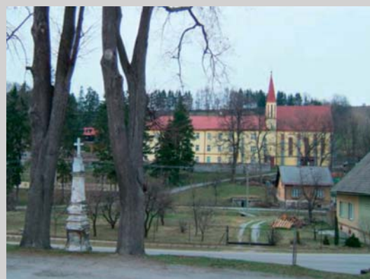
Klášteř včetně kaple - v tomto klášteři bylo nahrazeno tepelné čerpadlo kaskádou kotlů VERNER umístěných v přílehlém objektu
